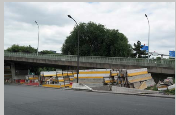
▲ Boulevard Ney Des glissières en béton ont été entreposées sous l'échangeur pour condamner un espace qui pourrait être occupé par des migrants.
